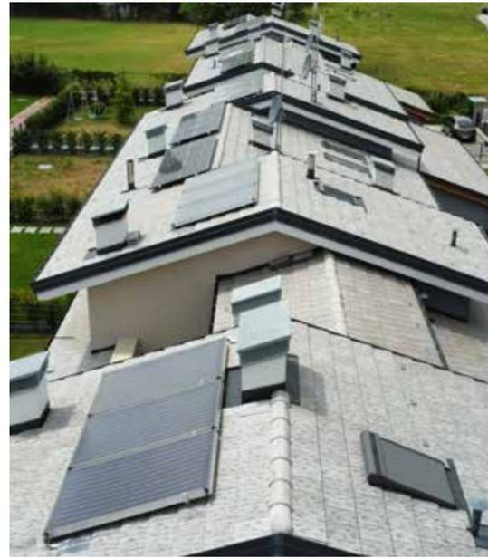
5. Esempi di impianti fotovoltaici in sovrapposizione al manto di copertura in laterizio: sopra, pannelli fotovoltaici per i tetti, colore Vieilli Lauze, delle villette a schiera a Cuneo; sotto, moduli fotovoltaici integrati sulle tegole con mix di colorazioni "antichizzate" - potenza 6,8 kWp Villa privata - fine '800 Pederobba (TV)
