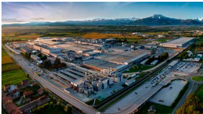
Stabilimento di Cuneo di Michelin con vista del sistema integrato di impianti sviluppato da Edison Next
