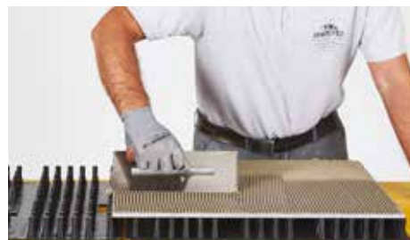
STESURA ADESIVO SUL RETRO DELLA PIASTRELLA
