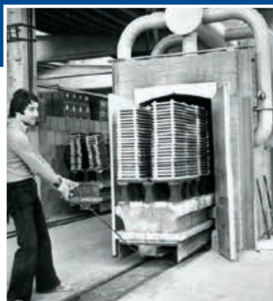
Estrazione del materiale cotto da un forno a tunnel degli anni '70.
