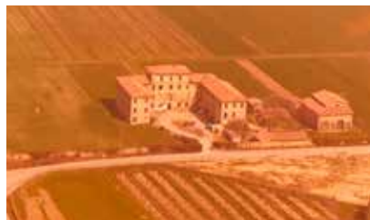
Foto aerea della Palazzina della Casiglia prima del restauro (prima metà degli anni '80).
