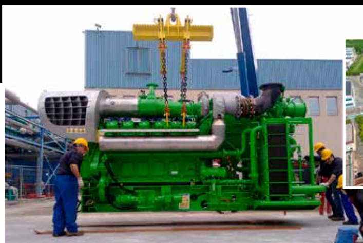
Installazione di un impianto di cogenerazione presso Farmaceutica Angelini e sede principale di CPL Concordia (MO).
